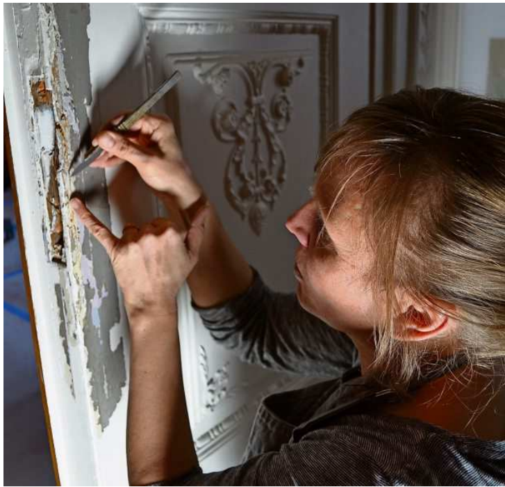
Restauratorin Britta Dierig löst mit einem Skalpell die einzelnen Farbschichten von der Holztür im Prinzenzimmer. Dabei ist neben handwerklichem Geschick eine besonders ruhige Hand gefordert. Fotos Zempel-Bley
